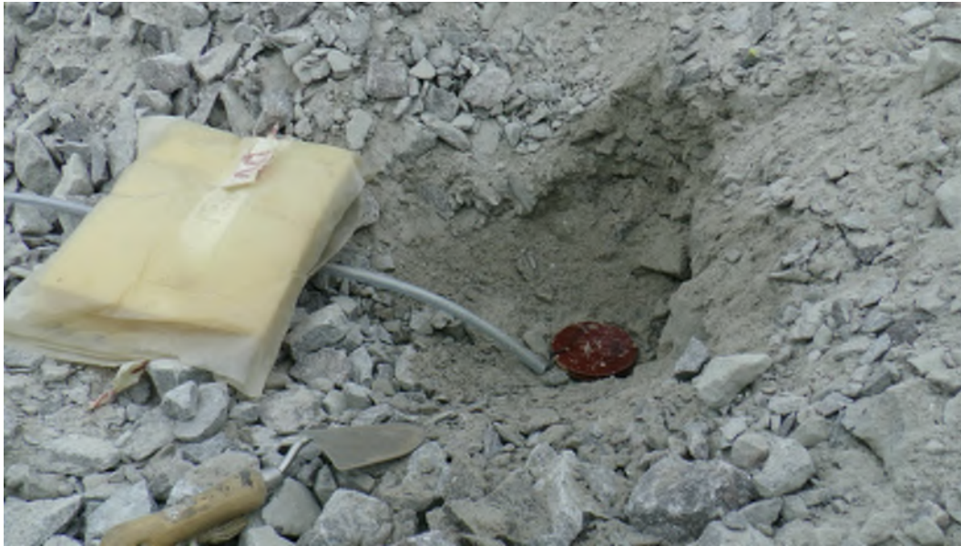
Figur 15. Installation av EMU-spolar.
