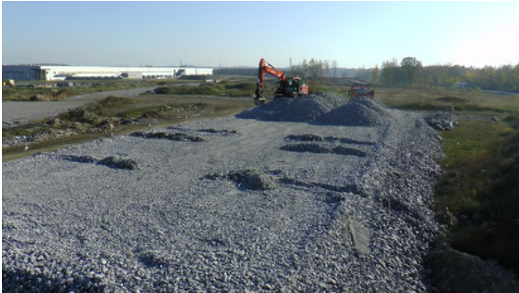
Figur 13. Hantering av massor på rampen.
