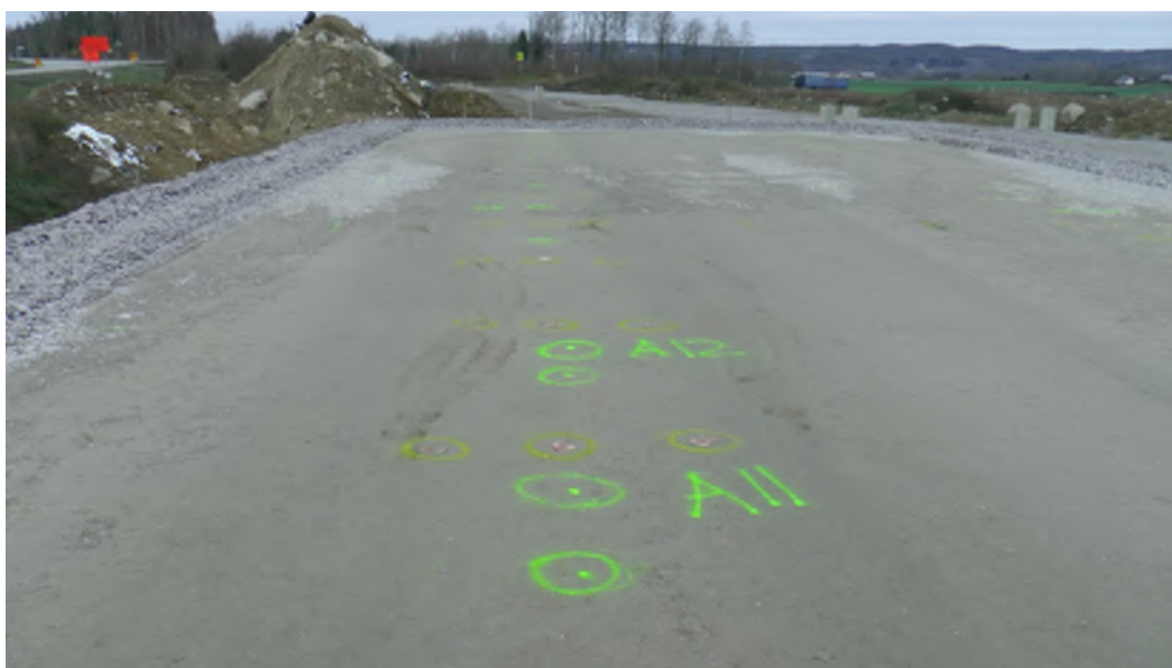
Figur 61. Finmaterial i ytan efter packning.
