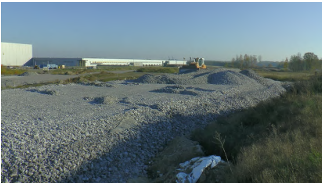
Figur 14. Utläggning av Lager 3B.
